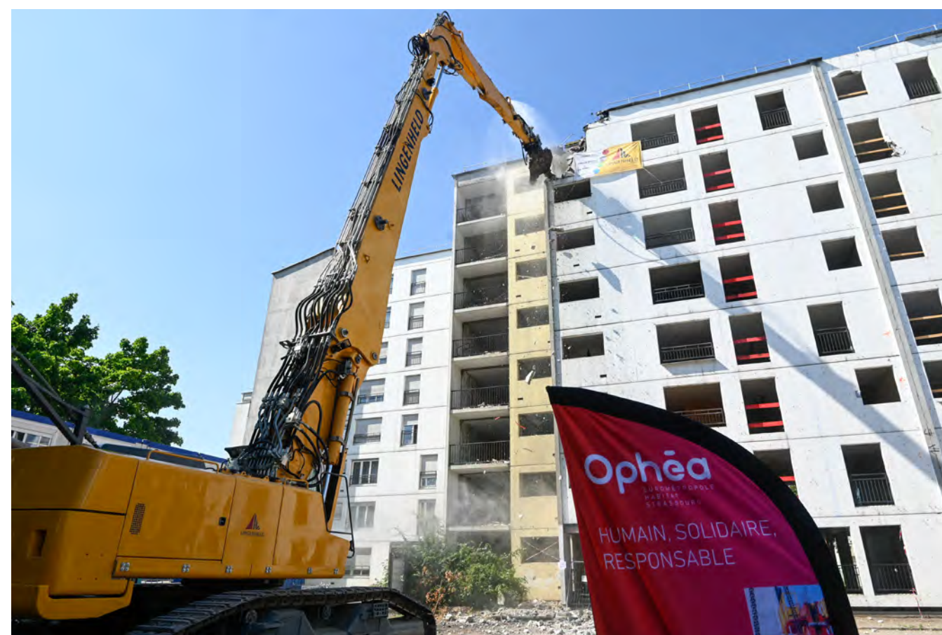
Démolition des 24 et 25 place Erasme, à Strasbourg-Hautepierre.
