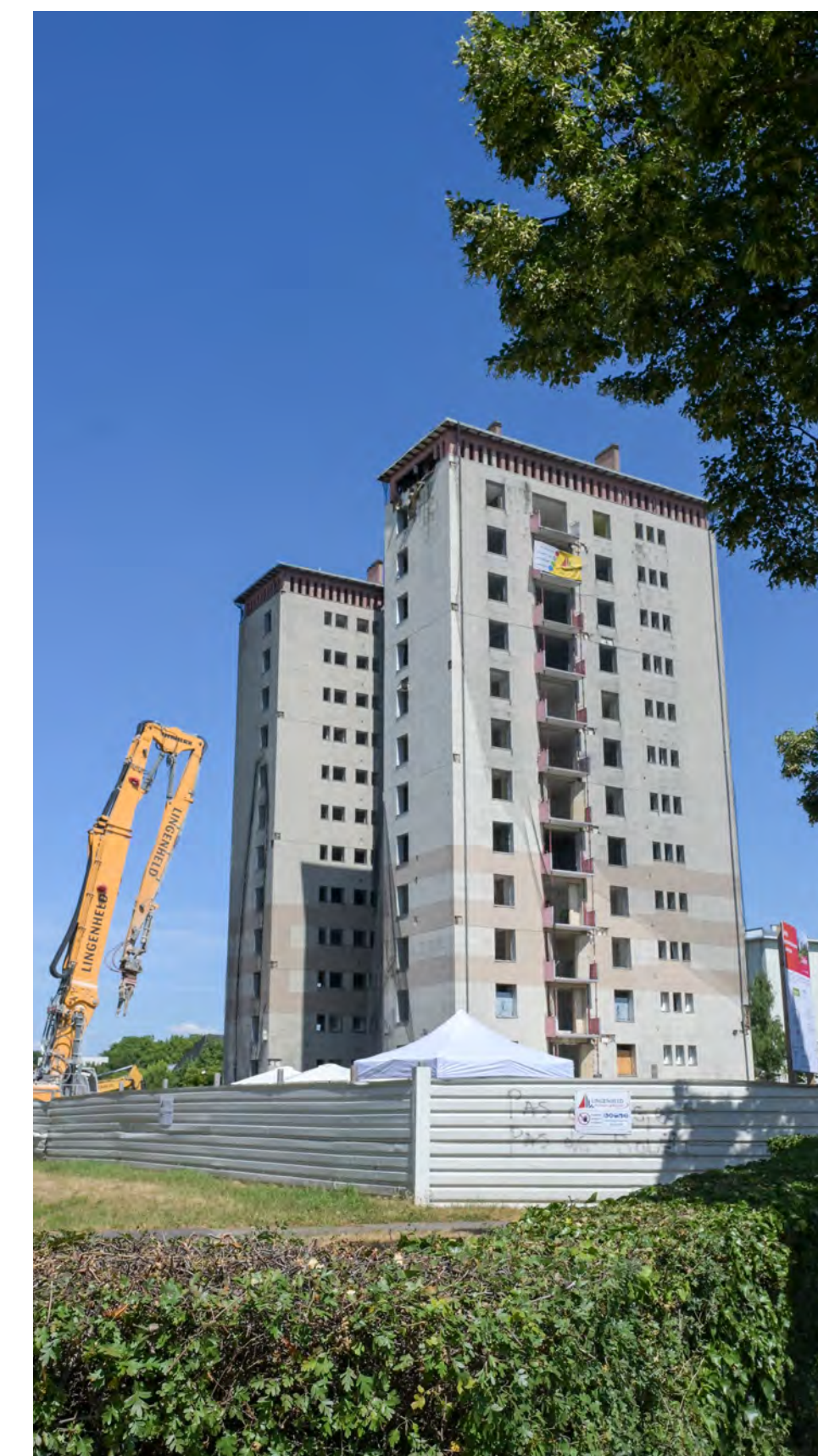
Démolition du 15 rue de Provence, à Strasbourg-Meinau.
