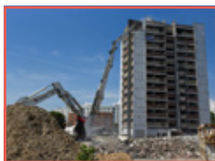
Cronenbourg - Rue Kepler 127 logements démolis en août 2021
