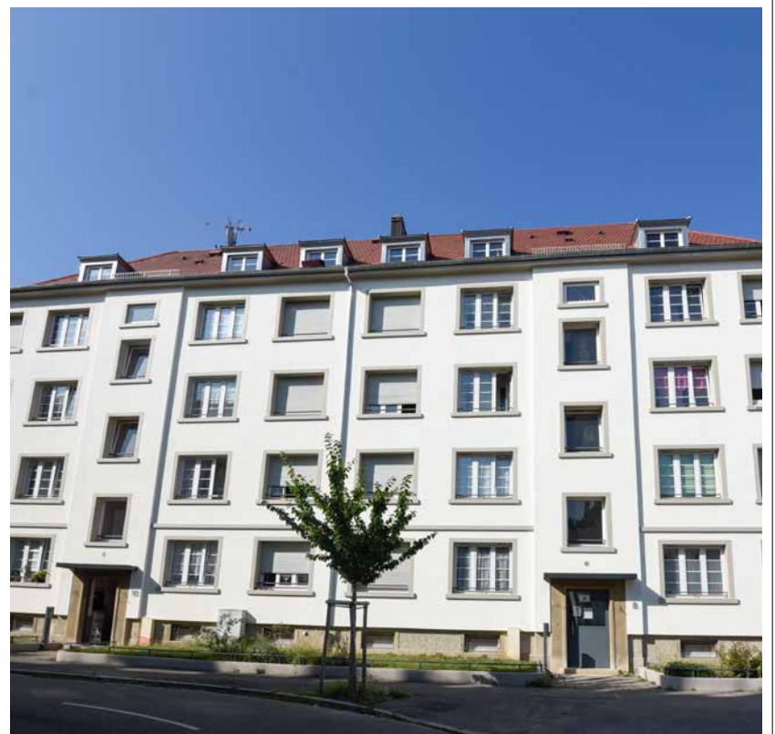
Strasbourg - Montagne Verte, Cité Sellier. La Cité à retrouver son aspect d'origine avec un niveau de confort amélioré.
