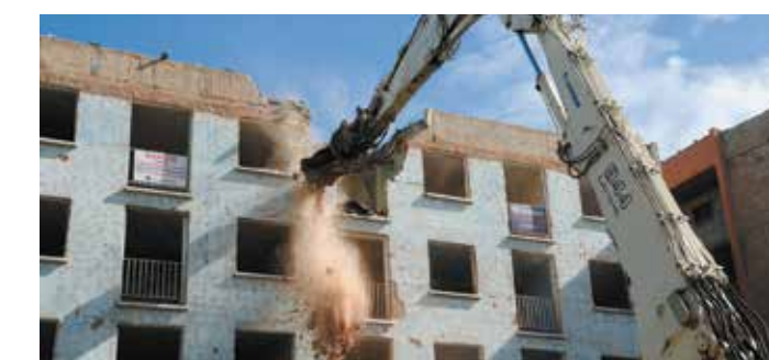
Démolition de 66 logements rue Gay Lussac
