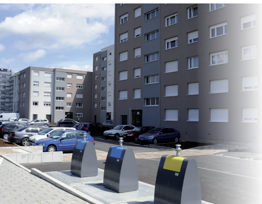
Nouveaux et discrets, des équipements enterrés de tri des déchets ont été installés, maille Karine.
