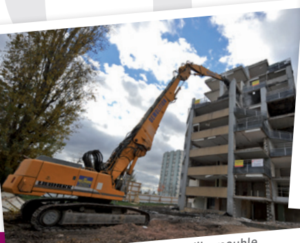
Démolition de l'immeuble 7, rue des Hirondelles à Lingolsheim... (2010)
