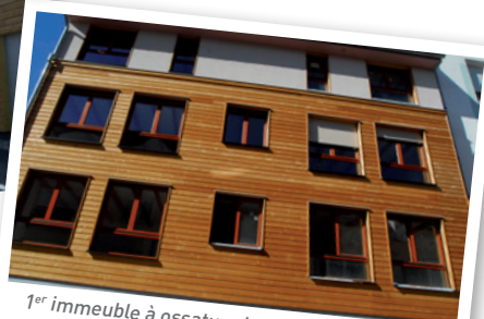
Constructions neuves rue du Général de Gaulle à Reichstett (2009)
