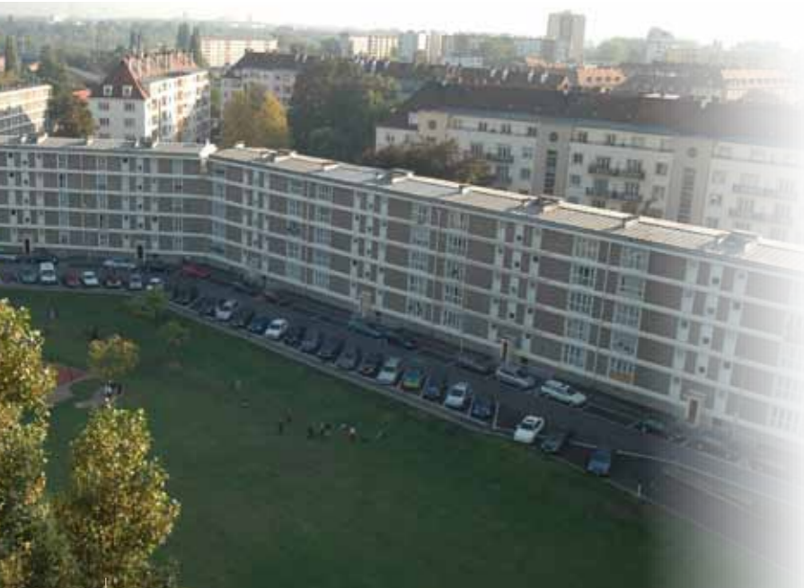
La Cité construite en 1953/54 a vieilli, mais elle garde des atouts très appréciés par ses habitants, parfois locataires depuis plus de 60 ans, témoins de la mixité générationnelle du quartier.
