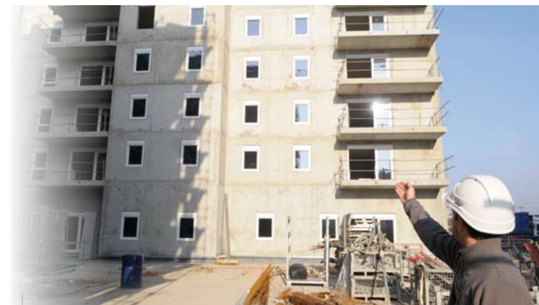
Gage de mixité pour la copropriété en construction au Bruckhof, ces appartements seront livrés à CUS Habitat en 2012.
