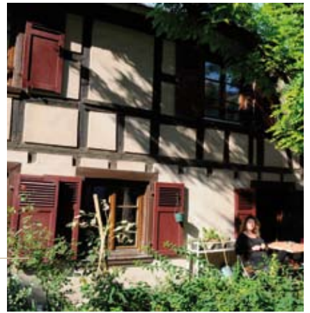
Des opérations de rénovation permettent de pérenniser le patrimoine du centre ville, comme ici, Cour des Zouaves à la Krutenau.
