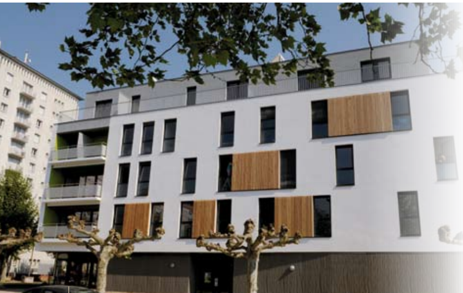
Le nouvel immeuble 15 rue Schulmeister, à la Meinau
