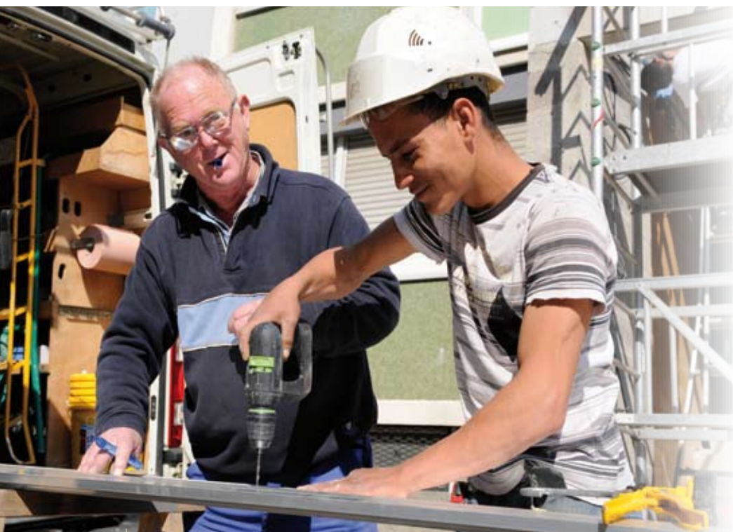
Youcef travaille au sein de l'entreprise STEINLE, sur un chantier en cours à Cronenbourg
