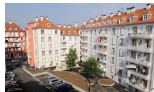
Rue Kentzinger, la cour intérieure a été réaménagée dans le cadre de la réhabilitation de l'ensemble.
