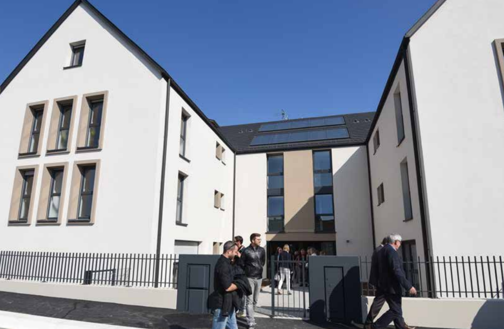
Au coeur de Niederhausbergen, le «1875» offre les 14 premiers logements locatifs sociaux de la commune.
